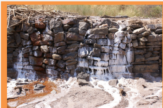
Figura 20. Detall de la precipitació de sal al torrent de Soldevila (Sallent). Aquest torrent no porta aigua, sinó salmorra saturada provinent del runam del Cogulló.
