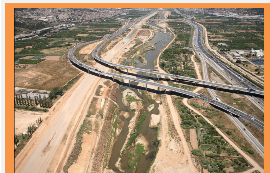
Figura 32. Infraestructures en l'espai fluvial
